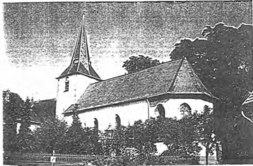
Bild 10 Die evangelische Kirche von Fränkisch-Crumbach, Grabeskirche der Herren von Rodenstein. Bilder 10-12 eigene Aufnahmen 1984
