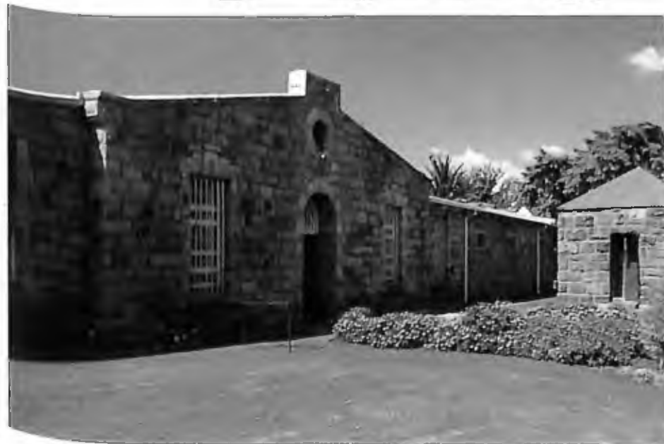
30 Das Klerksdorp-Museum, in dem unter anderem die bei Ottosdal (Transvaal) gefun- denen Metall-Massivkugeln mit umlaufenden Rillen ausgestellt sind.
